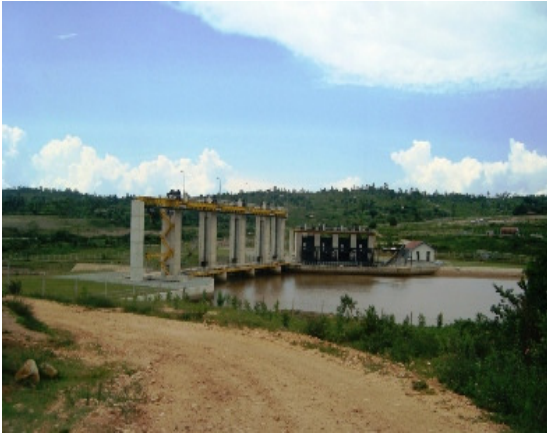
Fig 3.13a: Sondur – Mirui HPP Intake
